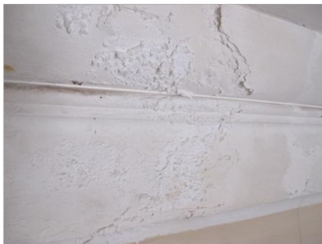
Figure 14 : Effritement du plâtre au niveau de la corniche.
