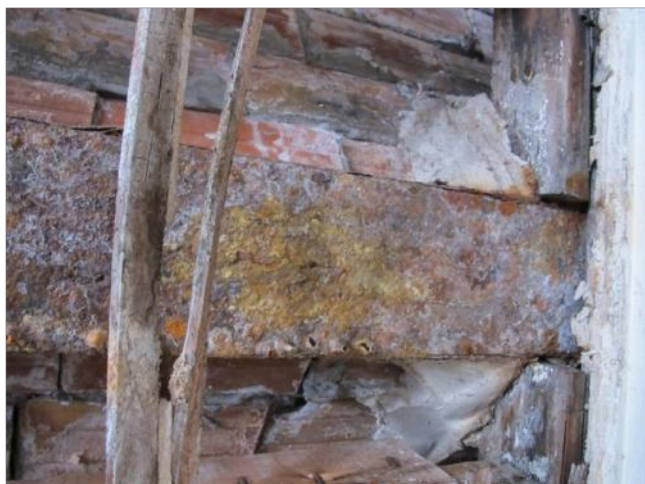
Figure 3 : Vue de la semelle inférieure de la poutre 1.
