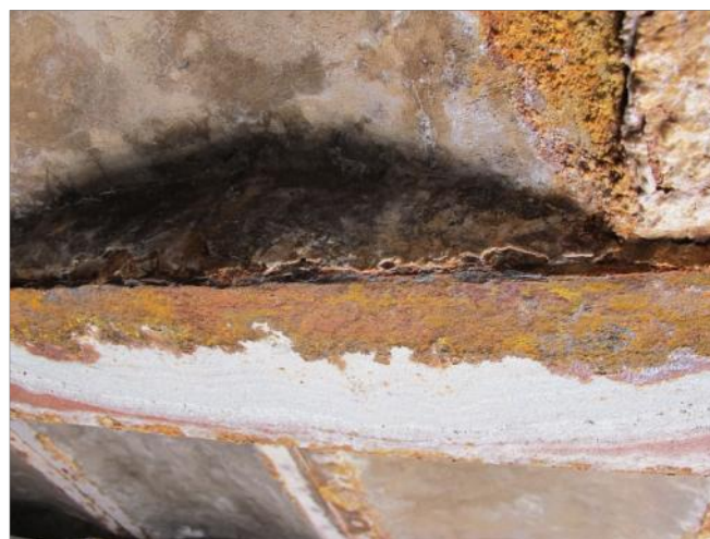
Figure 27 : Etat de la poutre après élimination des produits de corrosion.
