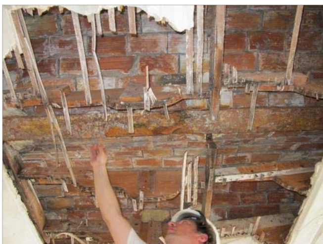
Figure 7 : Vue d'ensemble de la zone effondrée mettant en évidence les dégâts présents au niveau de l'ossature du staff.
