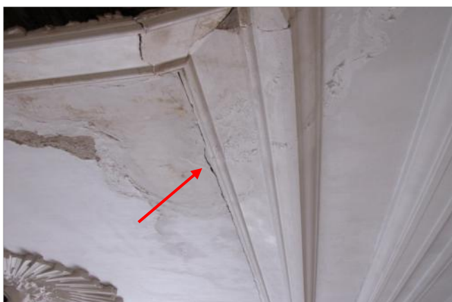
Figure 10 : Fissure dans le staff parcourant toute la longueur du plafond.
