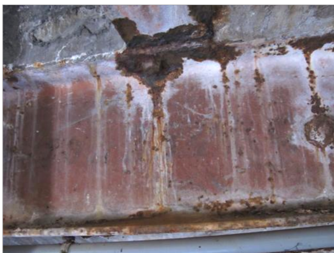
Figure 18 : Ame de la poutre Nord.
