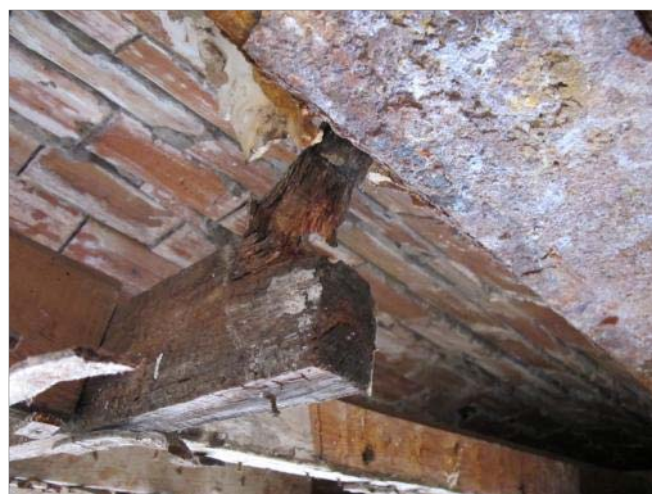
Figure 8 : Vue de détail d'un élément du châssis rompu au niveau d'une jonction avec une poutre métallique.
