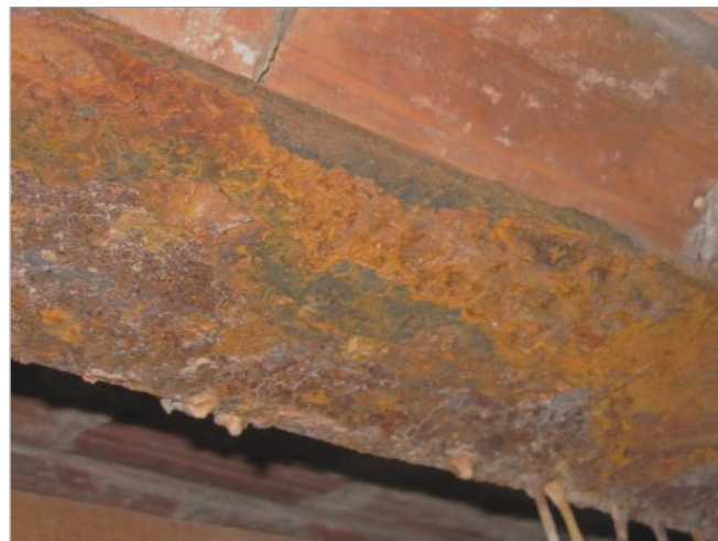
Figure 6 : Etat de corrosion de la semelle inférieure de la poutre 1 après élimination partielle des produits de corrosion.
