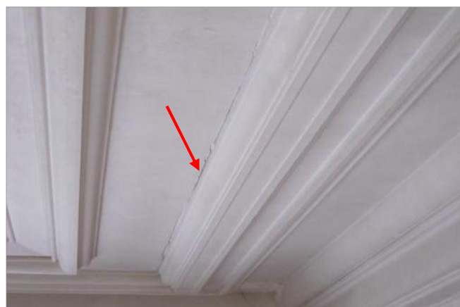
Figure 11 : Autre fissure dans le staff parcourant toute la longueur du plafond.
