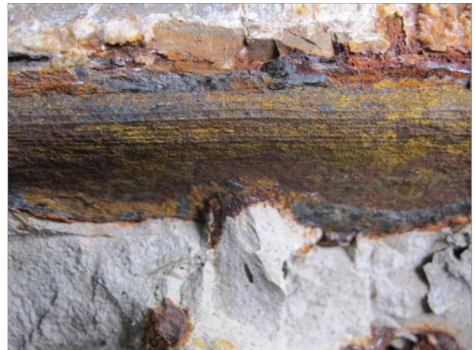
Figure 20 : Vue des stries de forge sur la cornière C3 après élimination de la gangue de concrétion.
