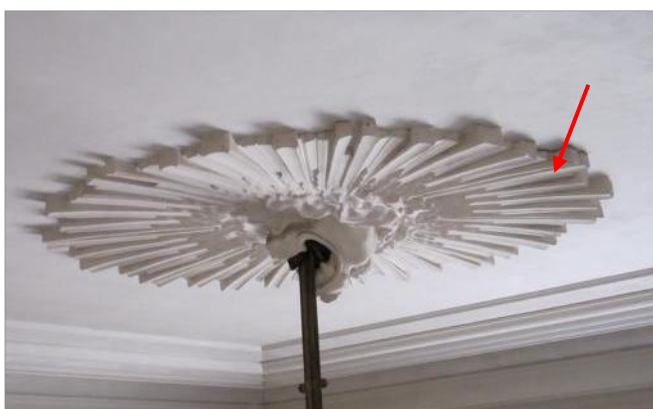
Figure 12 : Fissure périphérique à la jonction entre le plafond et la crinière du lion.
