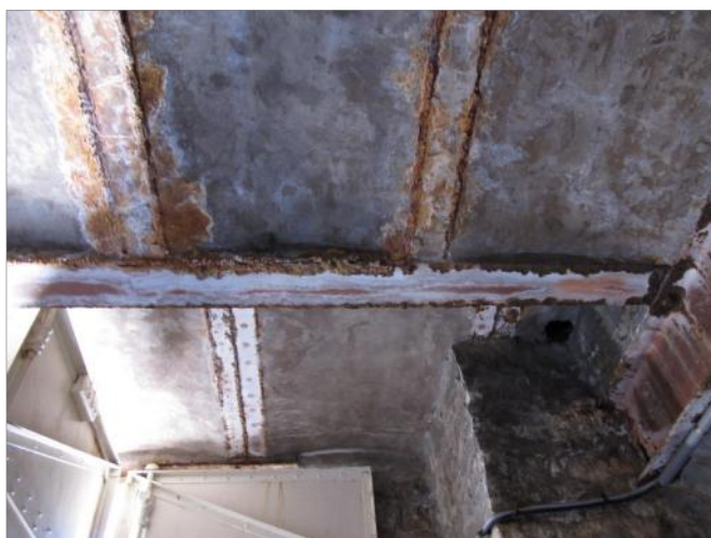
Figure 26 : Vue d'ensemble de la poutre Ouest entre les cornières C5 et C6.
