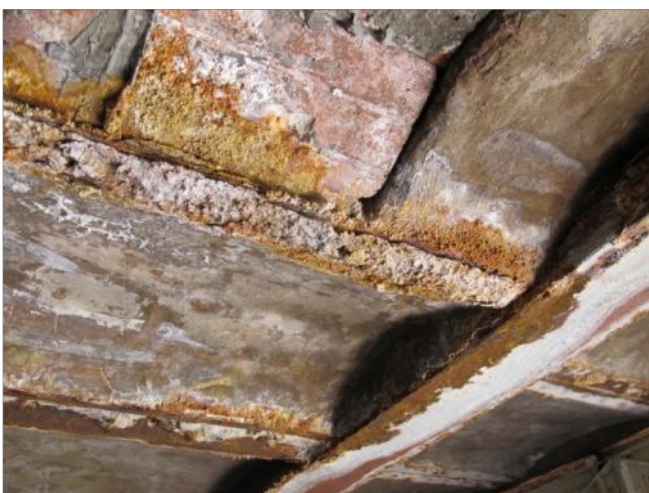
Figure 24 : Té recouvert de produits de corrosion.
