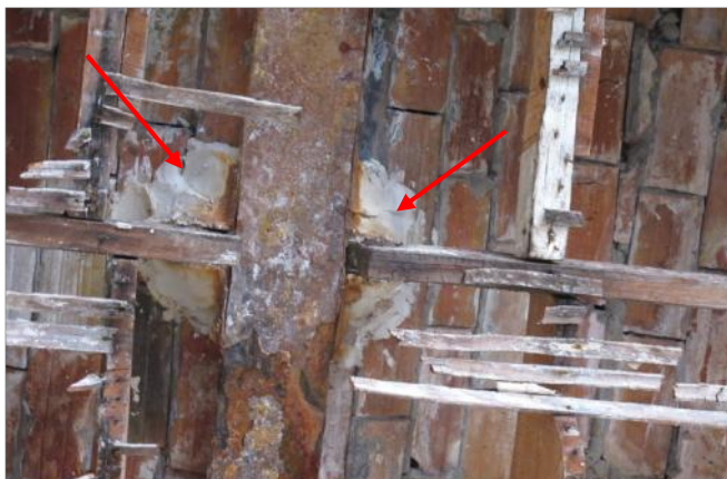
Figure 9 : Scellement en plâtre à la jonction châssis en bois et poutre métallique.
