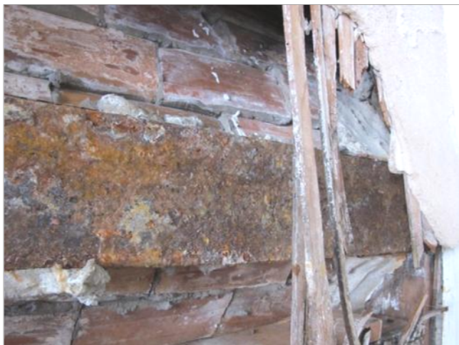
Figure 5 : Vue de la semelle inférieure de la poutre 2.
