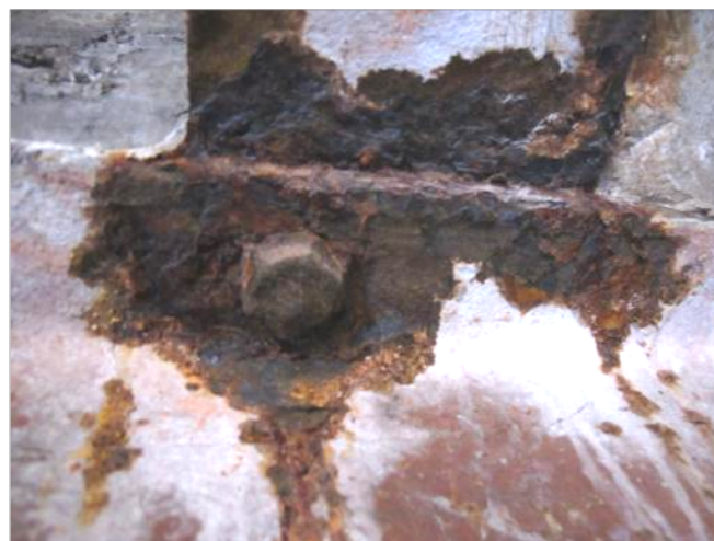
Figure 17 : Idem après élimination des produits de corrosion.
