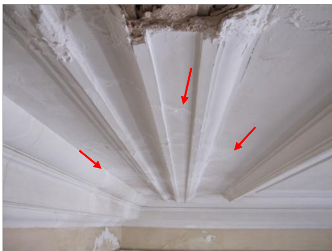
Figure 13 : Pulvérisation du plâtre du plafond.
