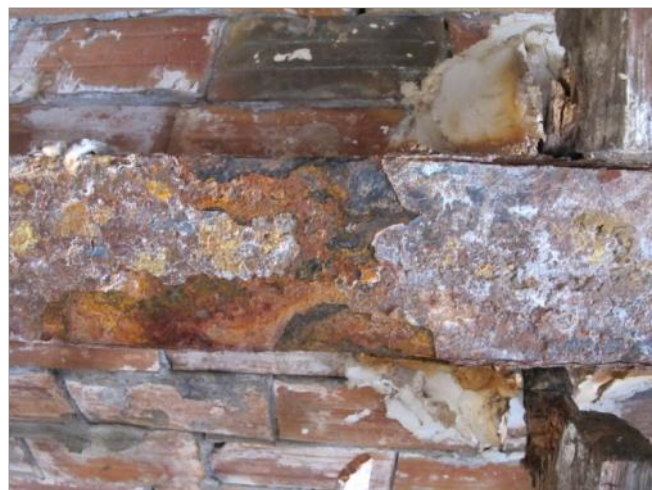
Figure 4 : Etat de corrosion de la semelle inférieure de la poutre 1 après élimination partielle des produits de corrosion.
