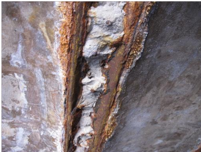
Figure 19 : Cornière C3 en cours de dégagement.
